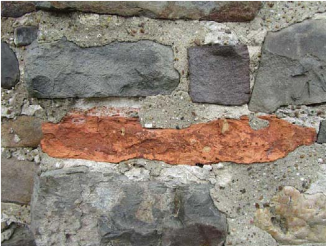
Afb. 33 Detail van het muurwerk in de kerk van Asselt met een lydion (met karakteristieke kleivlekken), waarop de resten van een Romeinse vloer in opus signinum zichtbaar is. (foto: Twan Ernst)
